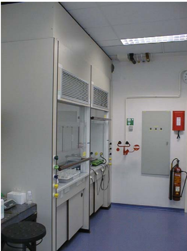
Figuur 3: Twee zuurkasten, de achterste met het raam open en de voorste met het raam gesloten
