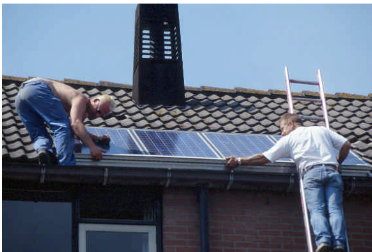
Figuur 3.2 Installatie van een dakgeïntegreerd PV-systeem
