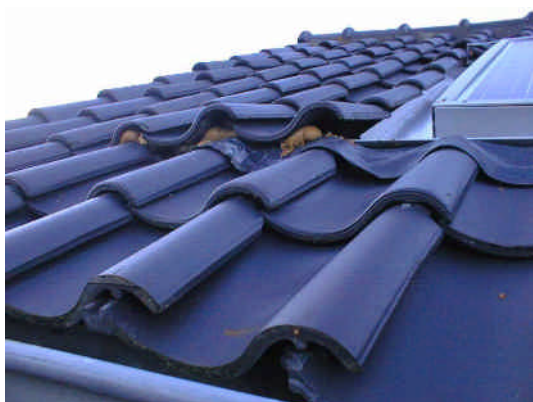
PUR-schuim als bevestiging. De dakpannen sluiten niet goed op elkaar aan
