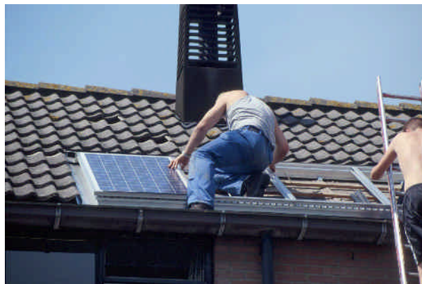
De installatie van een dakgeïntegreerd PV-systeem
