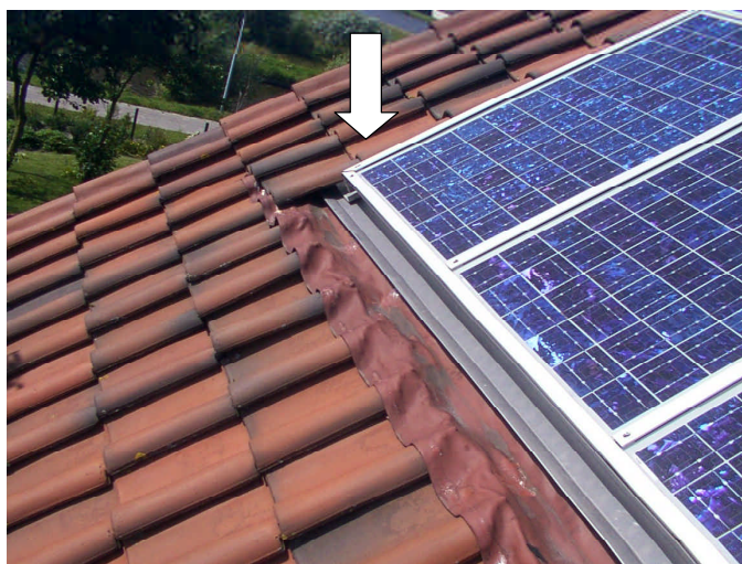
Figuur 5.1 Aan de zijde van dit PV-systeem is water in de woning gelekt
