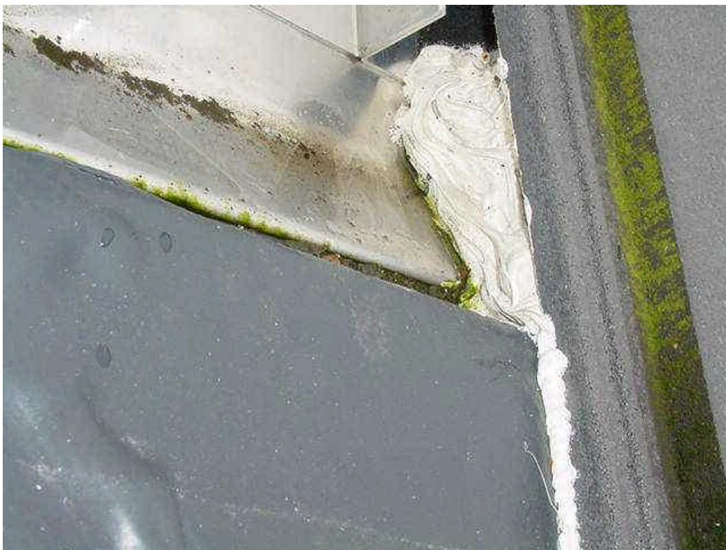
Dichten van een gat tussen de goot onder de PV-panelen en betonnen dakpannen
