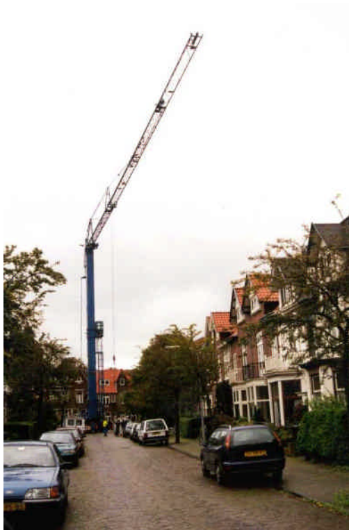
Voor de installatie van het PV-systeem op slecht bereikbare daken was de kraan nodig
