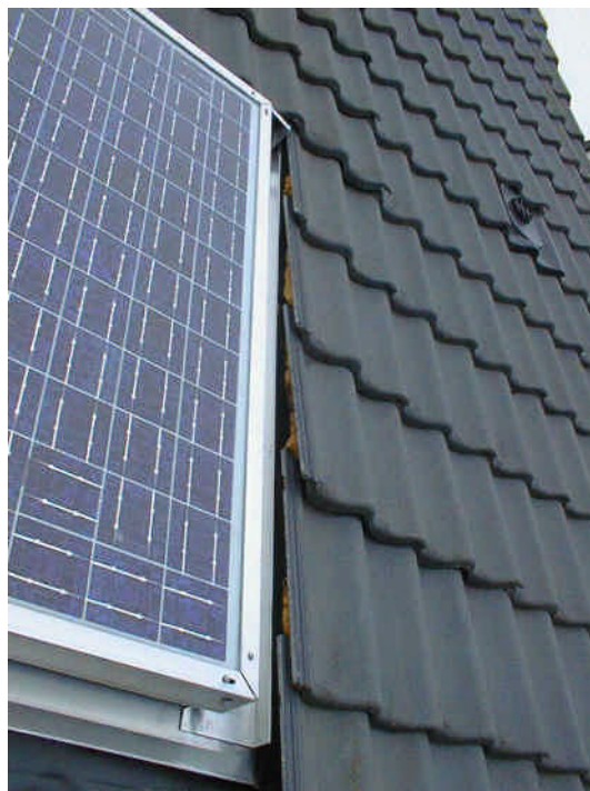
Mogelijke lekkage, dakpannen sluiten niet goed aan op het frame
