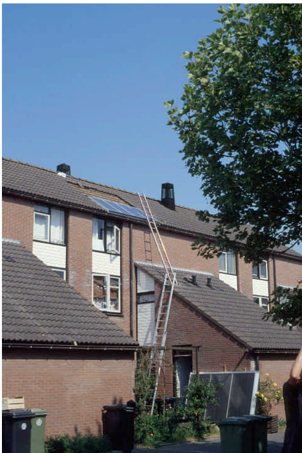
Nadat het PV-systeem op het dak is geïnstalleerd, wordt ook de zonneboiler geplaatst
