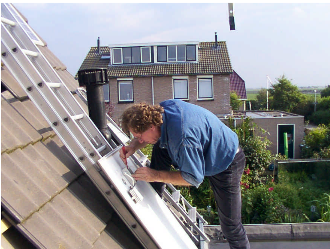
Figuur 3.4 Vervangen van een inverter op de achterzijde van een PV-paneel
