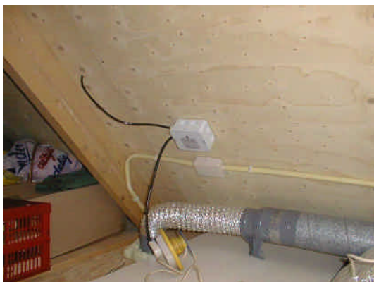
Figuur 3.8 Zonnestroomindicator wordt vaak geplaatst vlakbij de doorvoer van een kabel door het dak op de zolder
