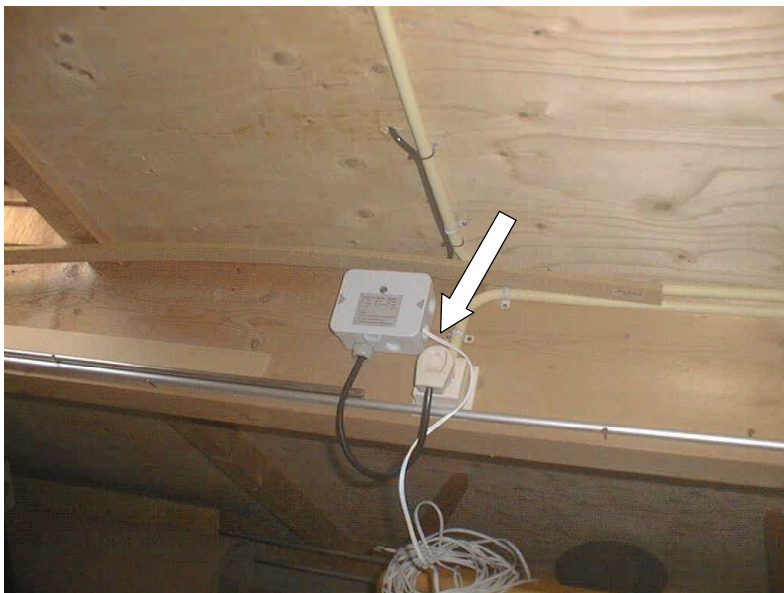
Aan de zijde van de zonnestroomindicator is de kabel voor de aansluiting op de computer i.v.m. de monitoring
