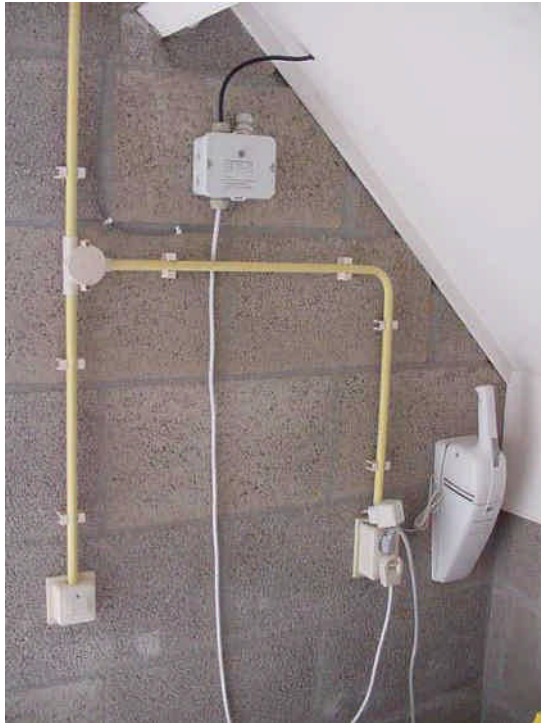
Doorvoer van de kabel door het dak, zonnestroomindicator en aansluiting op het paneel
