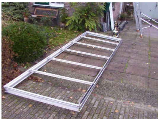
Het frame van het PV-systeem waar PUR-schuim gebruikt was. De deelnemer heeft gekozen voor een ombouw naar het systeem op beugels
