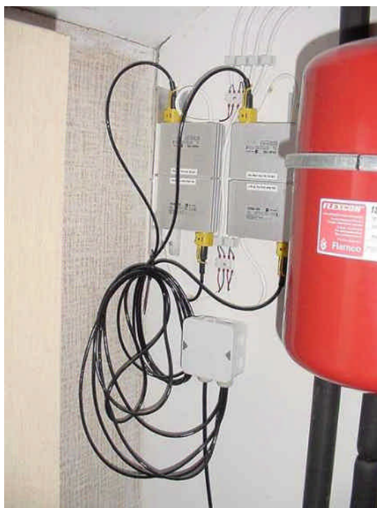
Inverters geïnstalleerd binnen - aansluitdoos en de bekabeling
