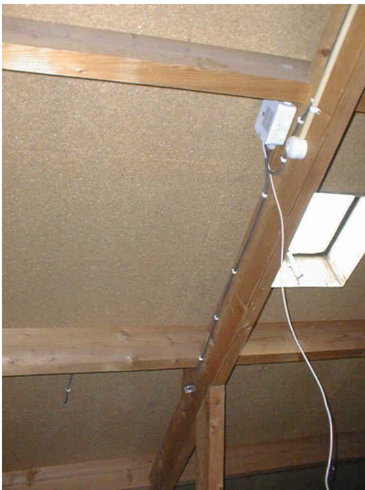
De zonnestroomindicator geplaatst vlakbij de doorvoer op de zolder. Eén kabel is op voldoende punten bevestigd, maar de andere hangt los in de ruimte
