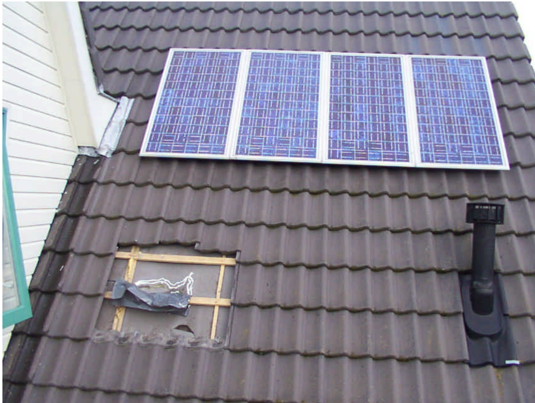
Beschadiging van het dak tijdens de installatie, waar de installateur op heeft gestaan. Bij slecht toegankbare daken moeten steigers gebruikt worden. Zie ook 5.2.4, punt 4.
