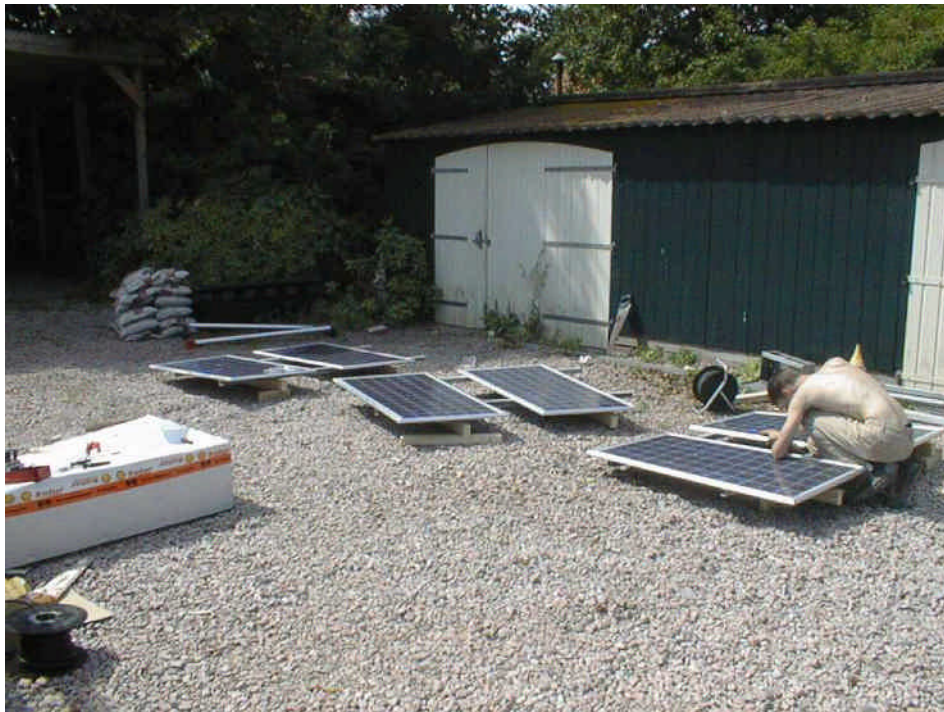
De PV-panelen op frames staan klaar om op het dak geplaatst te kunnen worden
