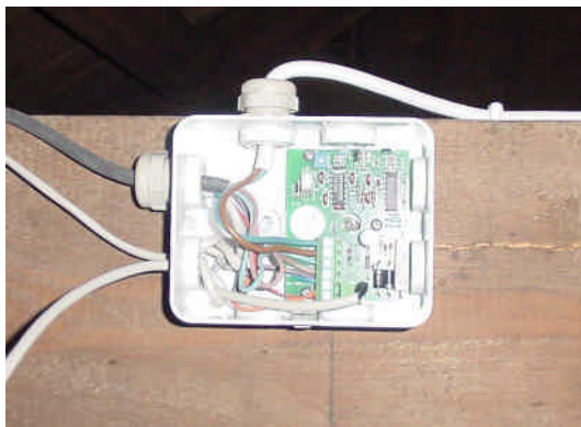
Doorvoer van de kabel door het dak, zonnestroomindicator en aansluiting op het paneel
