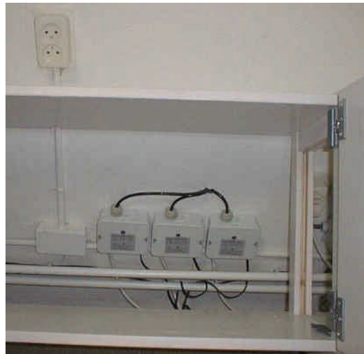
Drie zonnestroomindicators voor 12 PV-panelen, aangesloten in drie groepen
