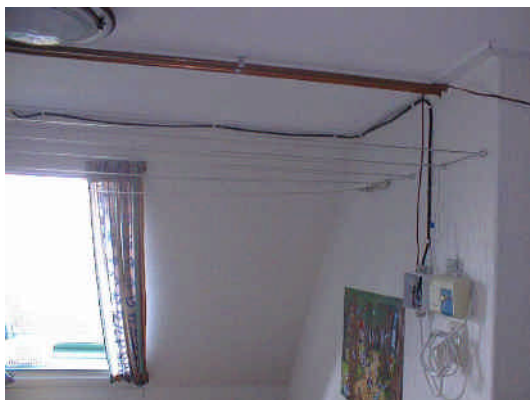
Slordige afwerking van de bekabeling in een woonruimte
