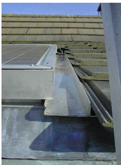
Detail van de randafwerking en de goot
