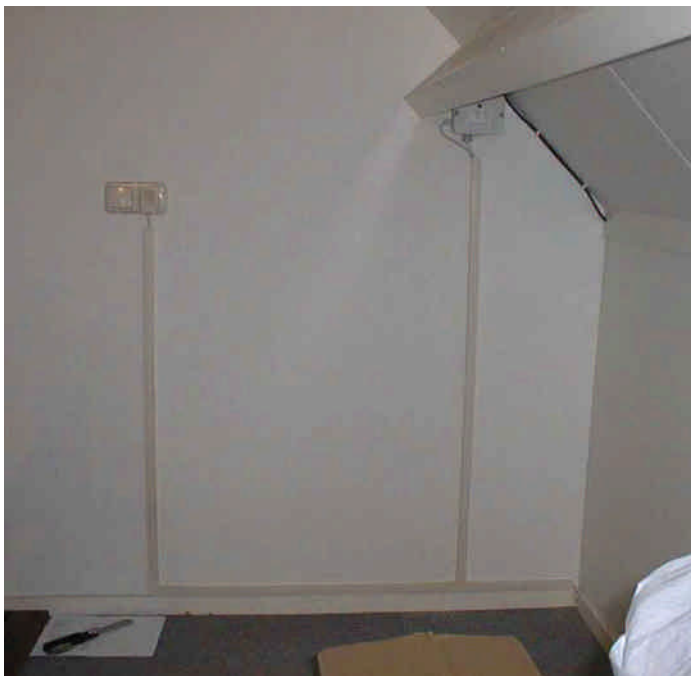
Figuur 3.5 Ventilatiepijp als doorvoer voor de kabels
