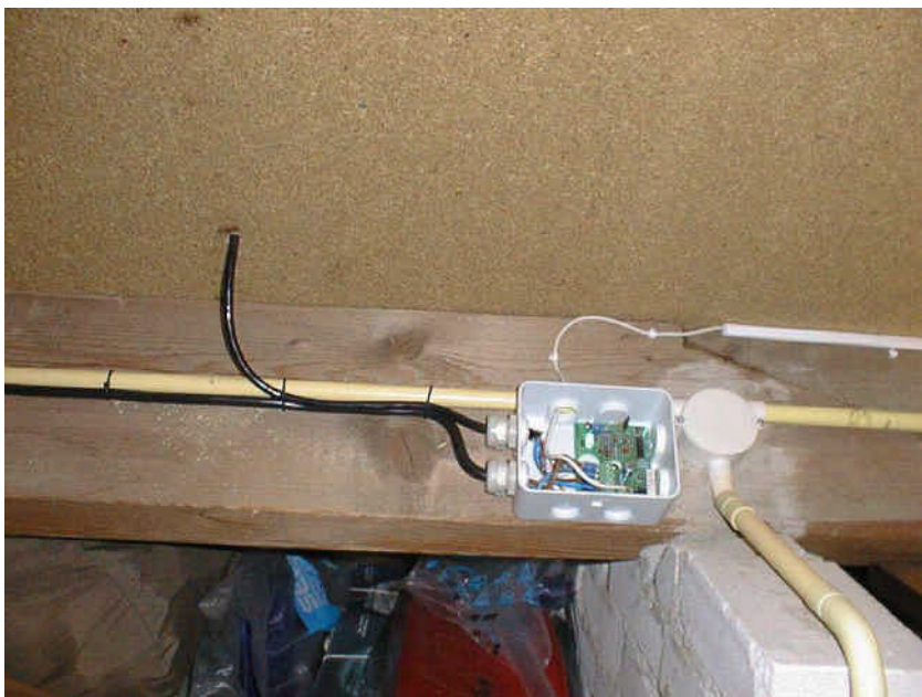
Een voorbeeld van de kabeldoorvoer en aansluiting op de zonnestroomindicator (open)
