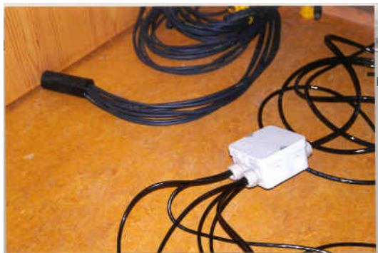
Twee bekabeling systemen voor buiten gebruikt in één PV-installatie (hulsje en een aansluitdoos)
