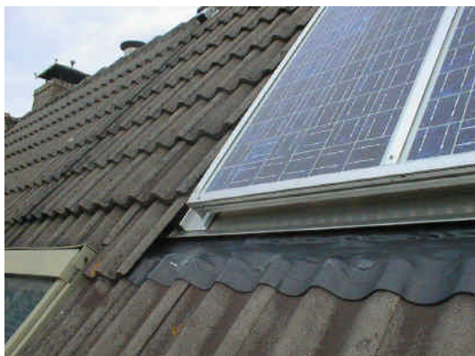
Detail van de aansluiting aan de dakpannen en de randafwerking aan de onderkant van de PV-panelen
