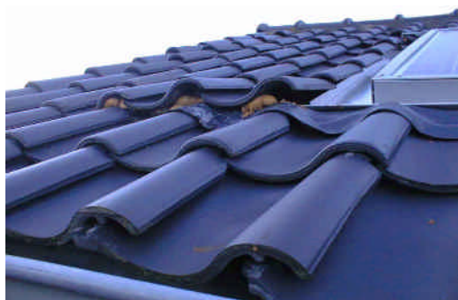
Figuur 3.3 Bevestiging van de dakpannen met behulp van het PUR-schuim
