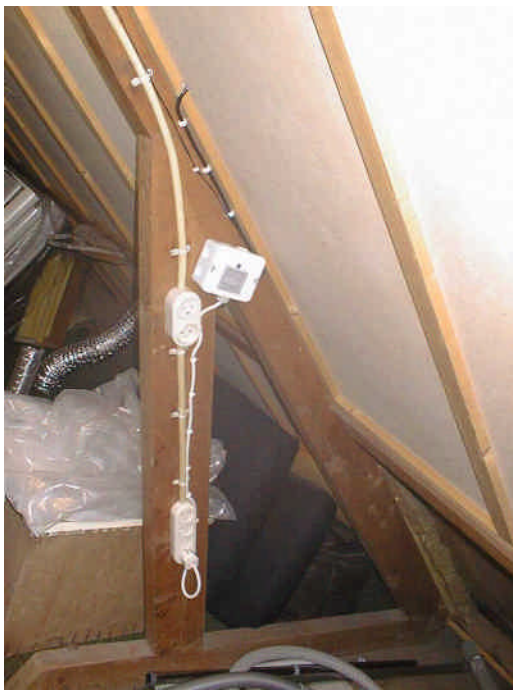
Zonnestroomindicator wordt vaak geplaatst vlakbij de doorvoer van een kabel door het dak op de zolder
