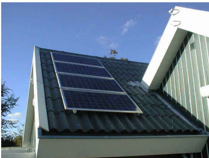
Figuur 3.1 Een voorbeeld van een PV-systeem op beugels
