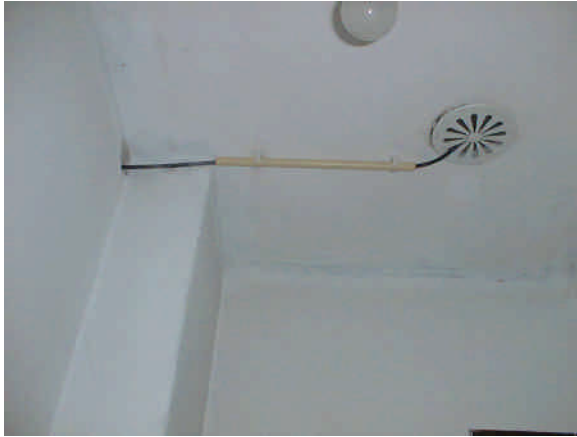
Figuur 3.5 Ventilatiepijp als doorvoer voor de kabels
