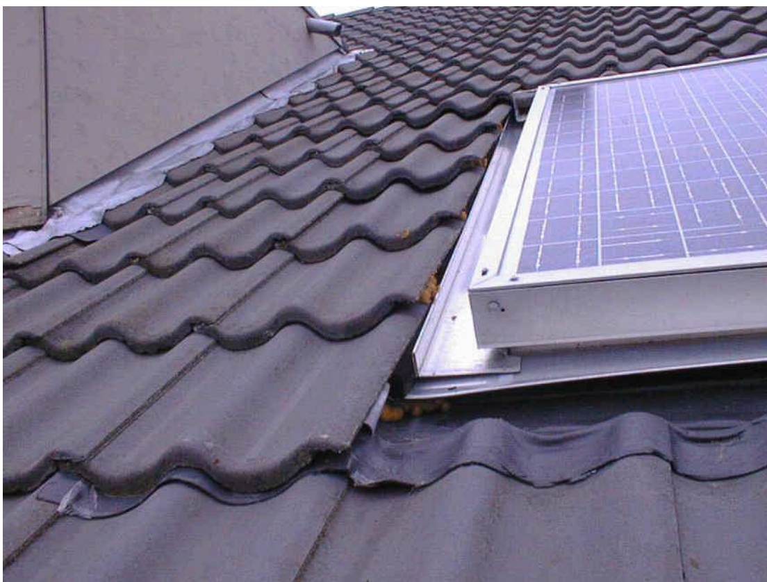
Bevestiging van dakpannen en afdichting van openingen met PUR-schuim
