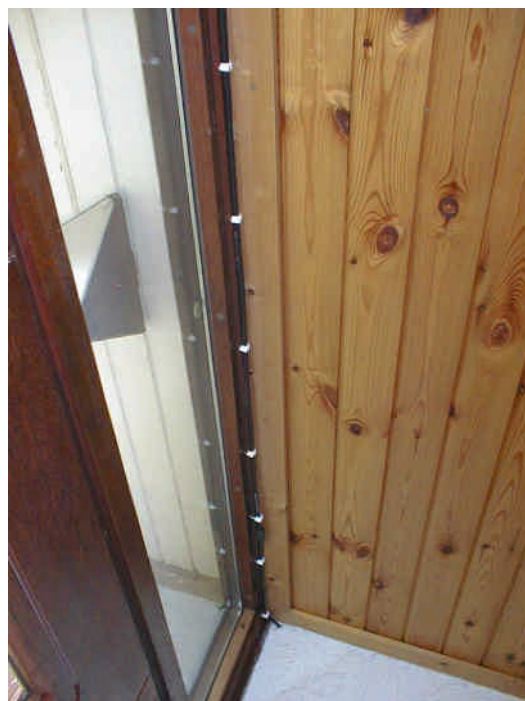
De kabel is op voldoende punten bevestigd. Een afdekking van de kabel ontbreekt nog
