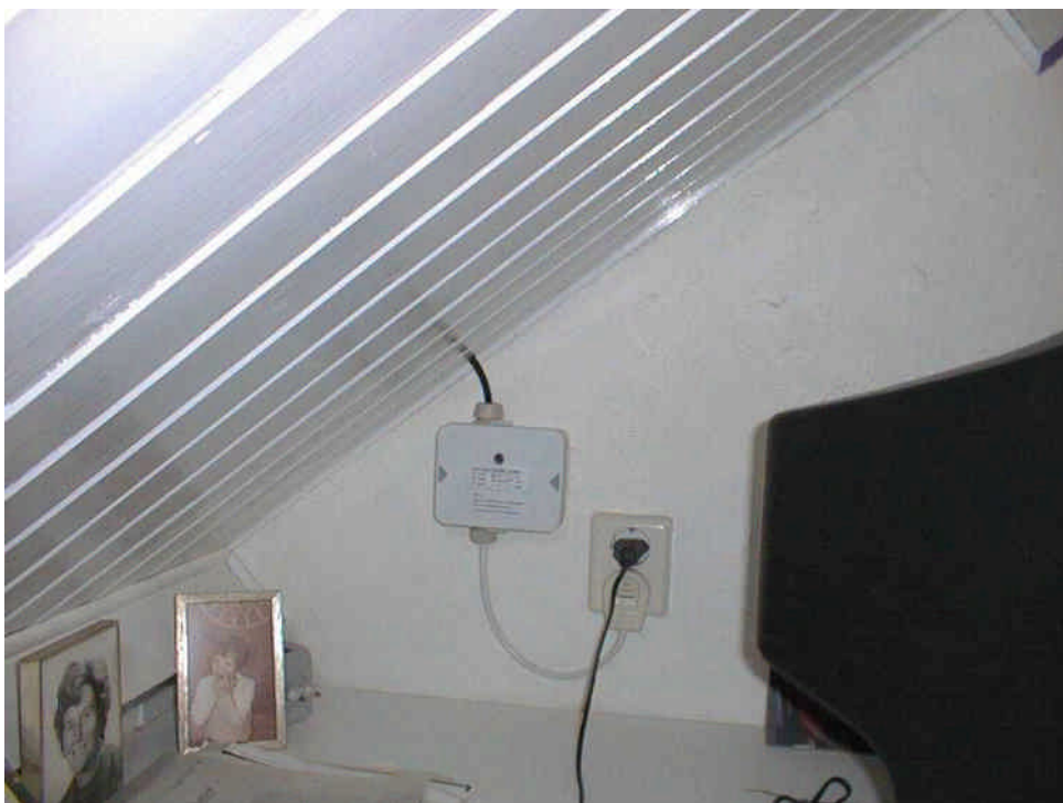
Nette en onopvallende afwerking van de doorvoer, zonnestroomindicator en de aansluiting op het netwerk
