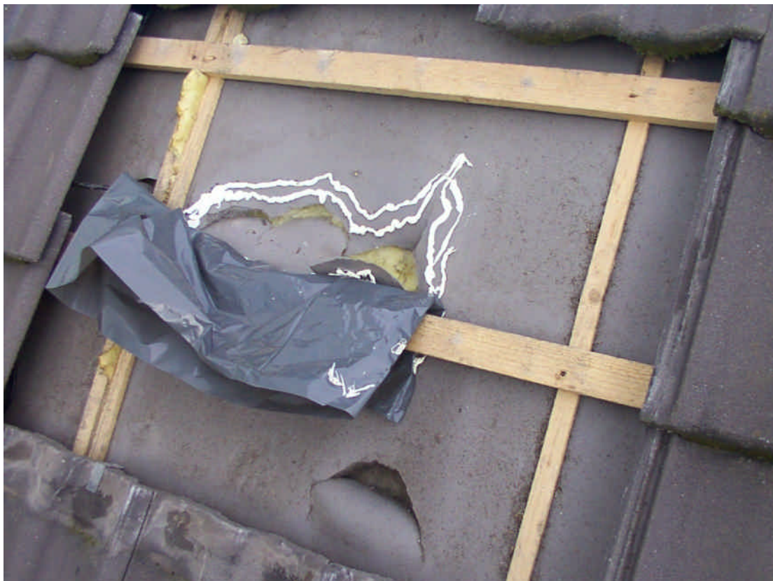
Detail van het dak waarop ook de beschadigde isolatie te zien is. Na het afronden van de werkzaamheden werd het dak met dakpannen gedicht. Zie ook 5.2.4, punt 4.
