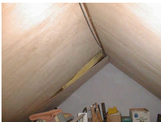
Beschadiging van de afdeklaag op zolder door de kabeldoorvoer
