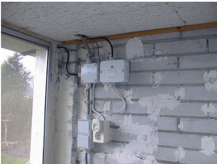
Voorbeelden van de netaansluiting met een schakelaar
