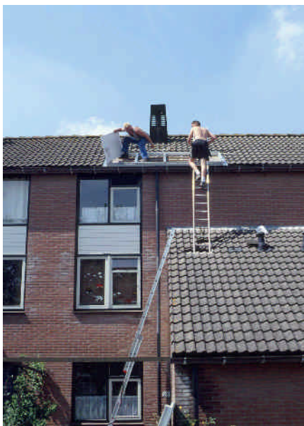
Veiligheid bij de installatie van dit PV-systeem is niet optimaal. De onbereikbaarheid van het dak vereist het gebruik van steigers
