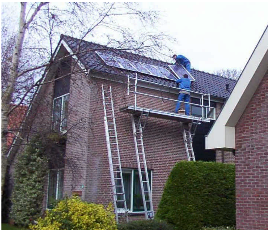
Zonder steigers zou de installatie op dit dak niet kunnen
