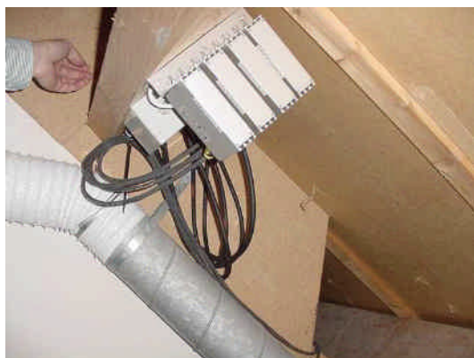
Inverter geïnstalleerd binnen op de zolder
