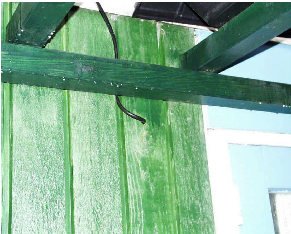
Verskillende voorbeelden van de doorvoer van een kabel naar binnen
