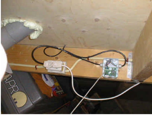
Zonnestroomindicator wordt vaak geplaatst vlakbij de doorvoer van een kabel door het dak op de zolder
