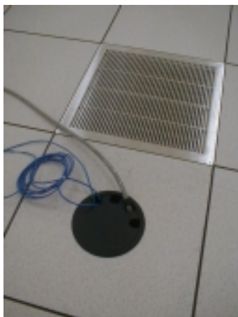
Figuur 4: Koude lucht en kabel toevoer
